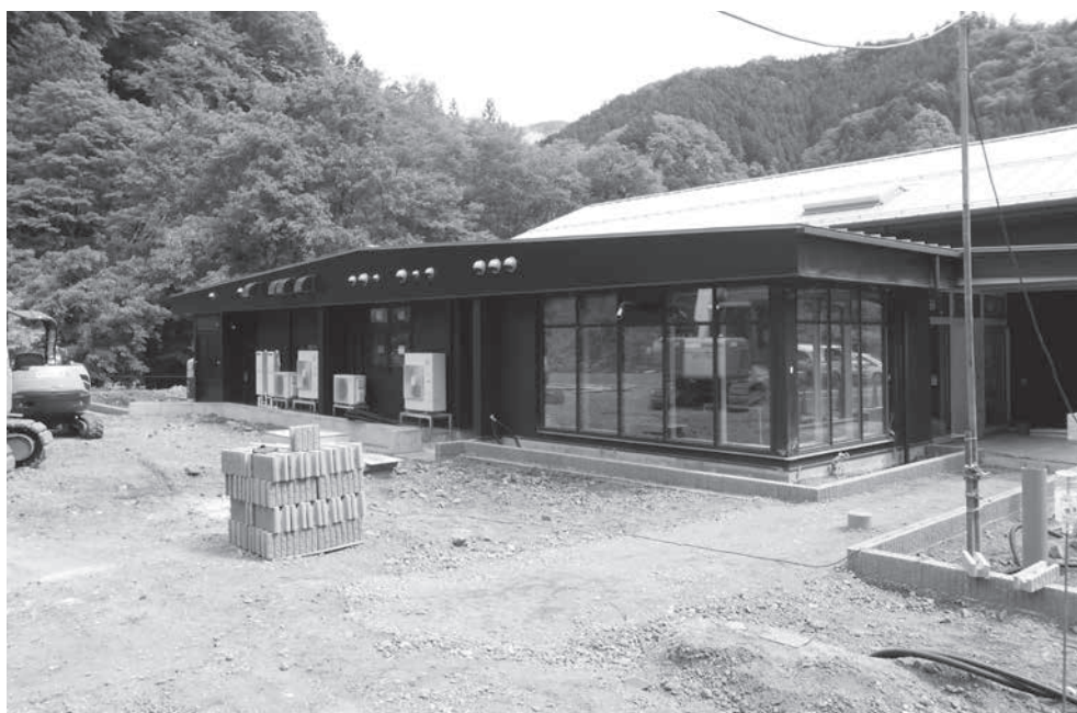
現在、外構工事を施工しています。
