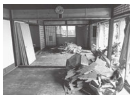
床剥がしを行った空き家
